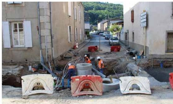
**Les travaux vont se poursuivre au-dessus de la Gendarmerie côté pairs jusqu'au Numéro 78 qui balise la fin de chantier.** Les trottoirs côté pairs seront normalement terminés, jusqu'à la gendarmerie et la chaussée sera mise à niveau et un bicouche bitumineux sera apposé afin d'obtenir un chantier « propre » pour la période estivale.
