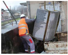
Une mauvaise surprise pourtant, évoquée et pressentie : la présence de matériaux amiantés dans la composition des collecteurs d'eaux usées a entraîné la mise en place d'une procédure adaptée, générant évidemment un surcoût
