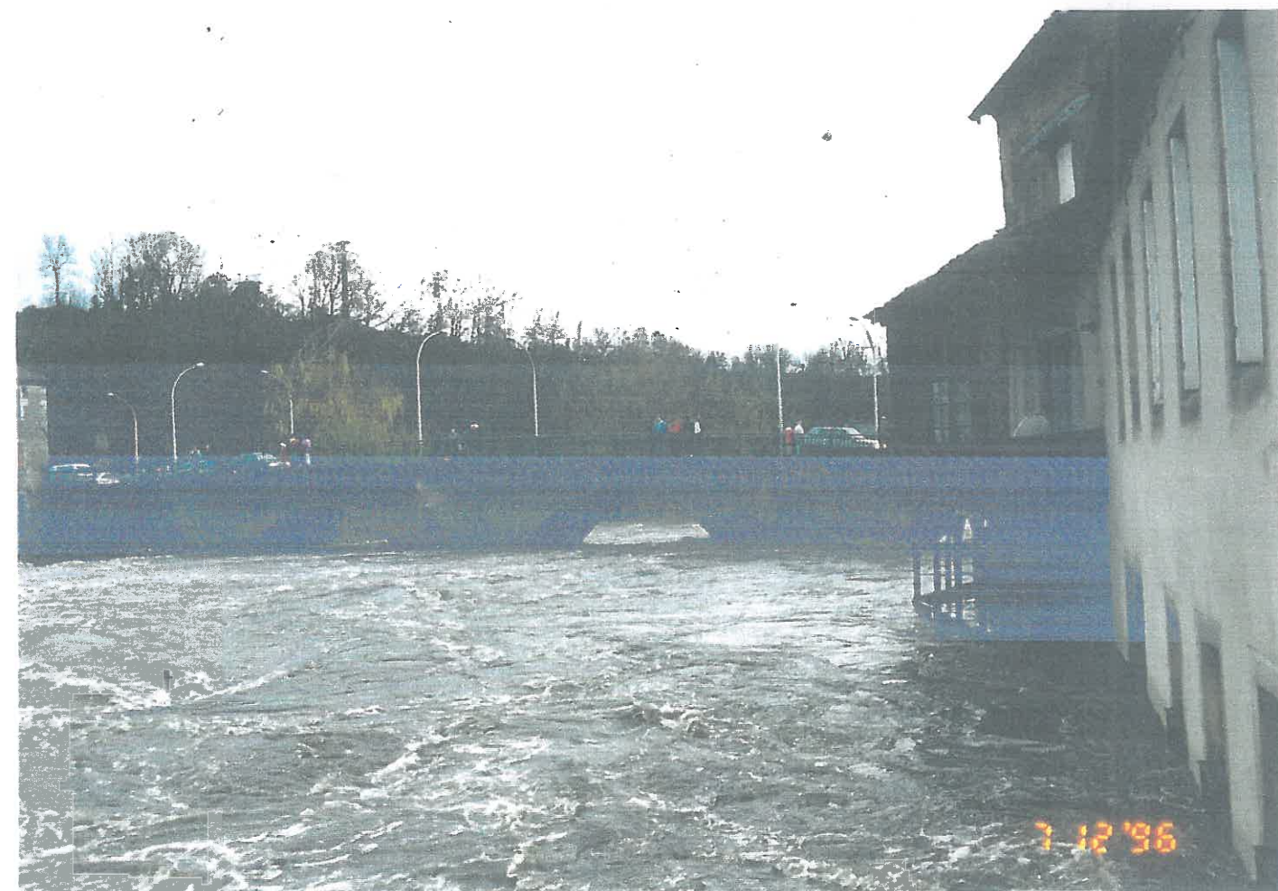
II - 20 / ROQUECOURBE - Le Pont
