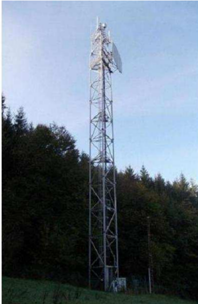
vue 1 : depuis l'entrée du site. Pas de modification de l'aspect extérieur.
