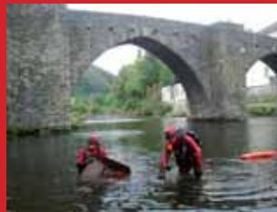
Le corps des sapeurs-pompiers du Tarn section plongée sous-marine est venu gracieusement examiner les piles du pont-vieux. Il en ressort un défouillement (usure) équivalent à la variation du niveau d'eau provoquée par les lâchers d'eau. La mairie va engager des travaux pour corriger ce « désordre » qui ne met pas pour l'instant en danger la structure de notre pont mythique. Les hommes grenouilles en ont profité pour récupérer une brouette ! Nous recherchons son propriétaire...
